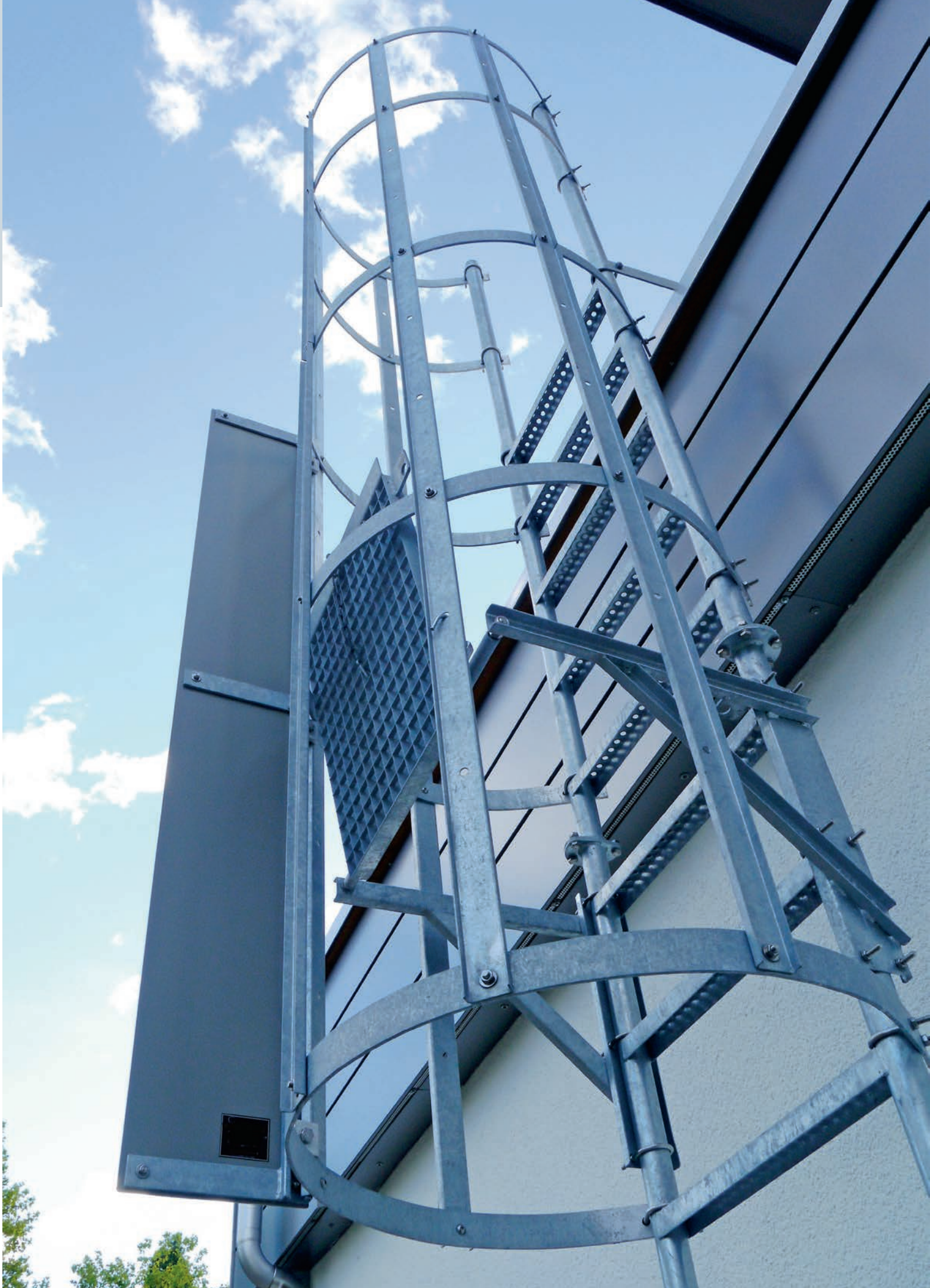
Eine spezielle Anforderung bildete die Befestigung im Bereich des Dachrandes.
