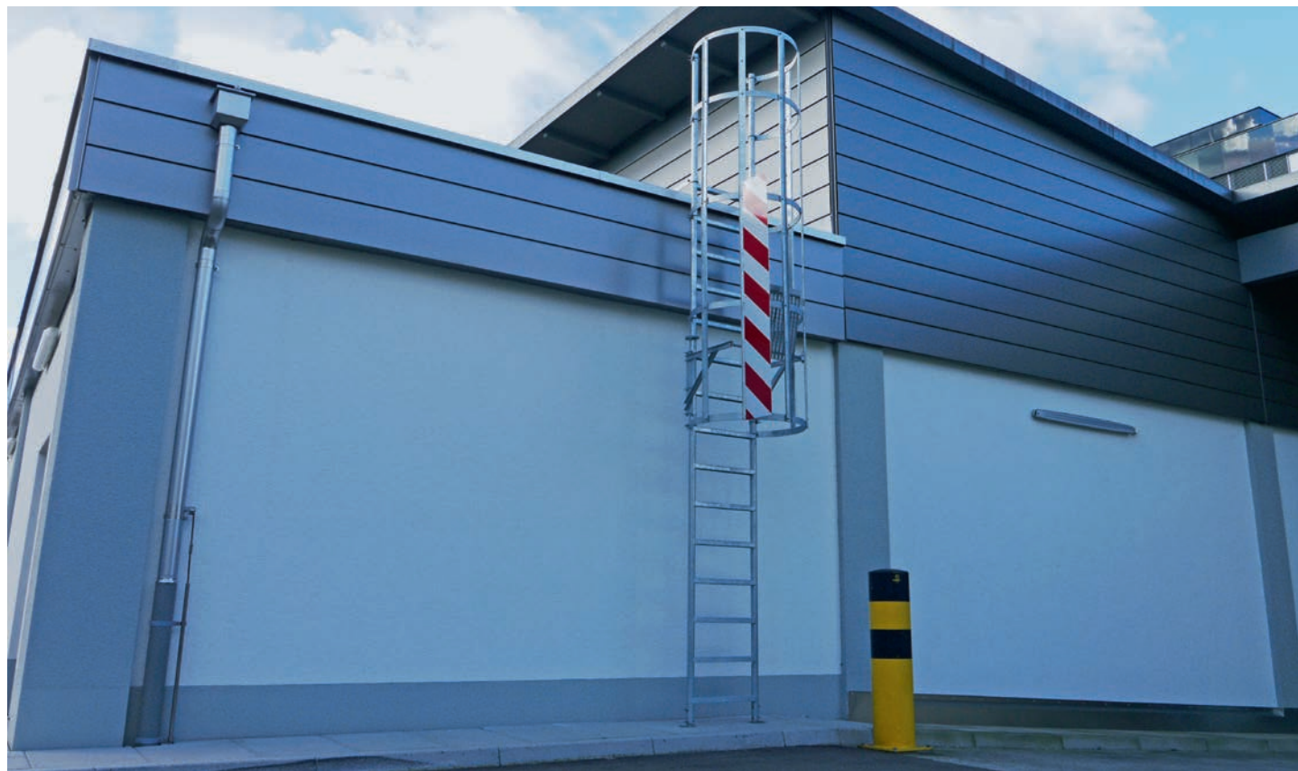
Sprich rüstete 15 Lidl-Filialen mit speziellen Steigleitern aus, versehen mit Rückenschutz.
